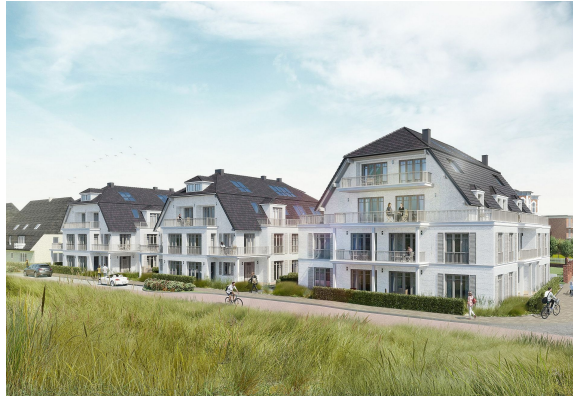
Salt & Rocks baut ganze Apartment-Siedlungen mit Hotel-Charakter. / Foto: Salt & Rocks
